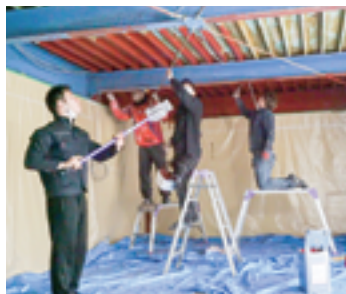
▲倉庫を改装中の様子
