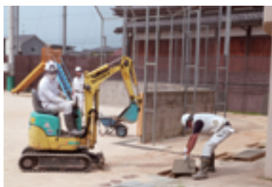
▲重機を使った土砂の除去作業
