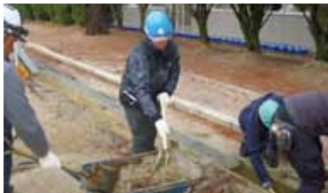
▲土砂を撤去する参加者ら
